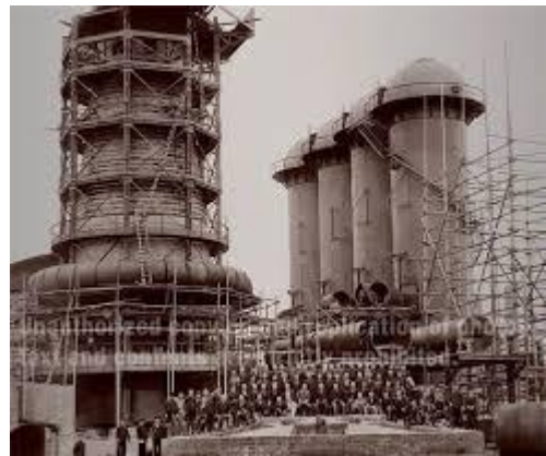
鉄鋼 八幡製鉄所
