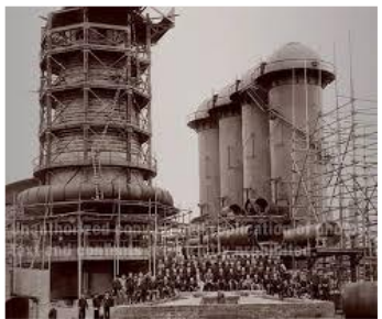
鉄鋼 八幡製鉄所
