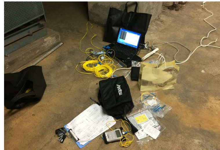
素人 ファイバー 接続工事
